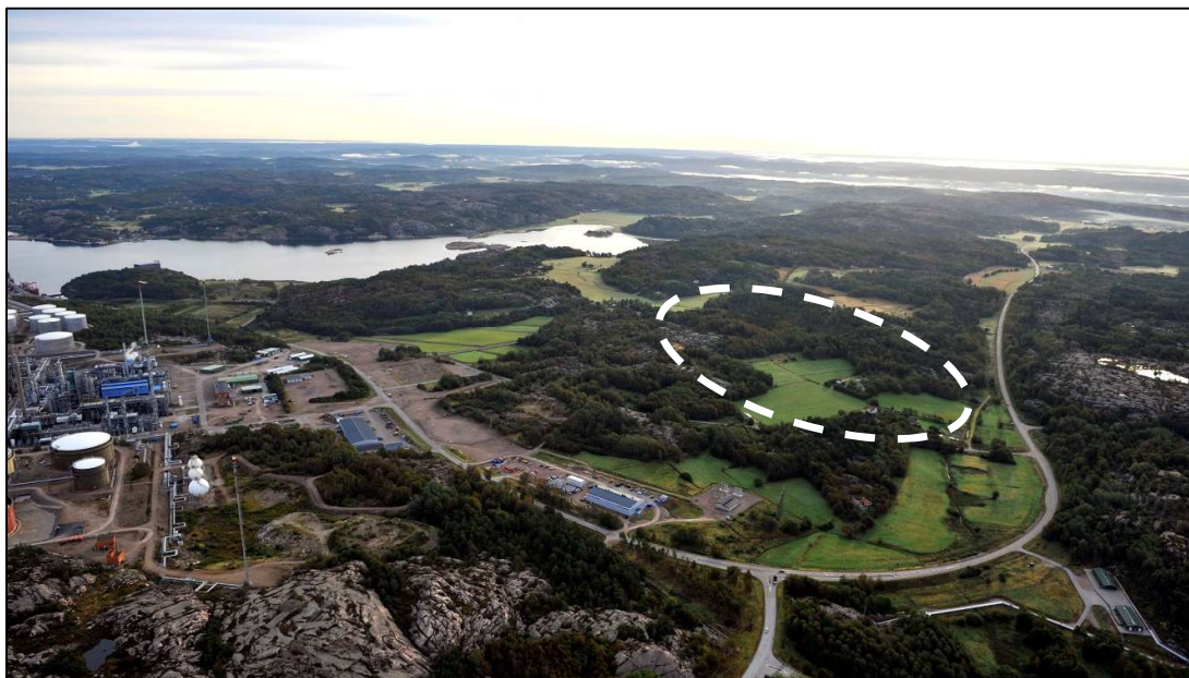
Figur 6. Ett planområde i anslutning till Preems raffinaderi vid Brofjorden har varit utgångspunkt för arbetet i Lysekil.
