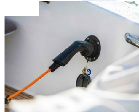
Figur 16. Pågående laddning av elbåt med kontaktdon typ 2 [1].
