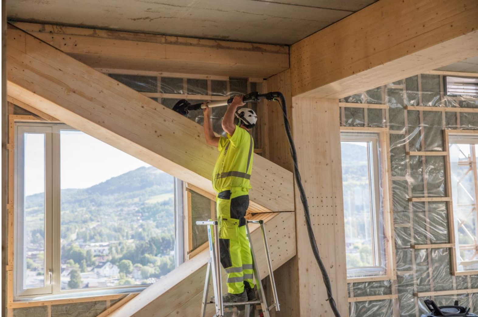
Synliga limträelement putsas vid behov för högsta finish
